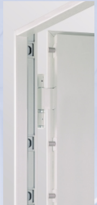
Sicherungsbolzen, Bandseite
